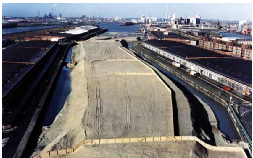
Backfilling of Bremen's Überseehafen, 1998
